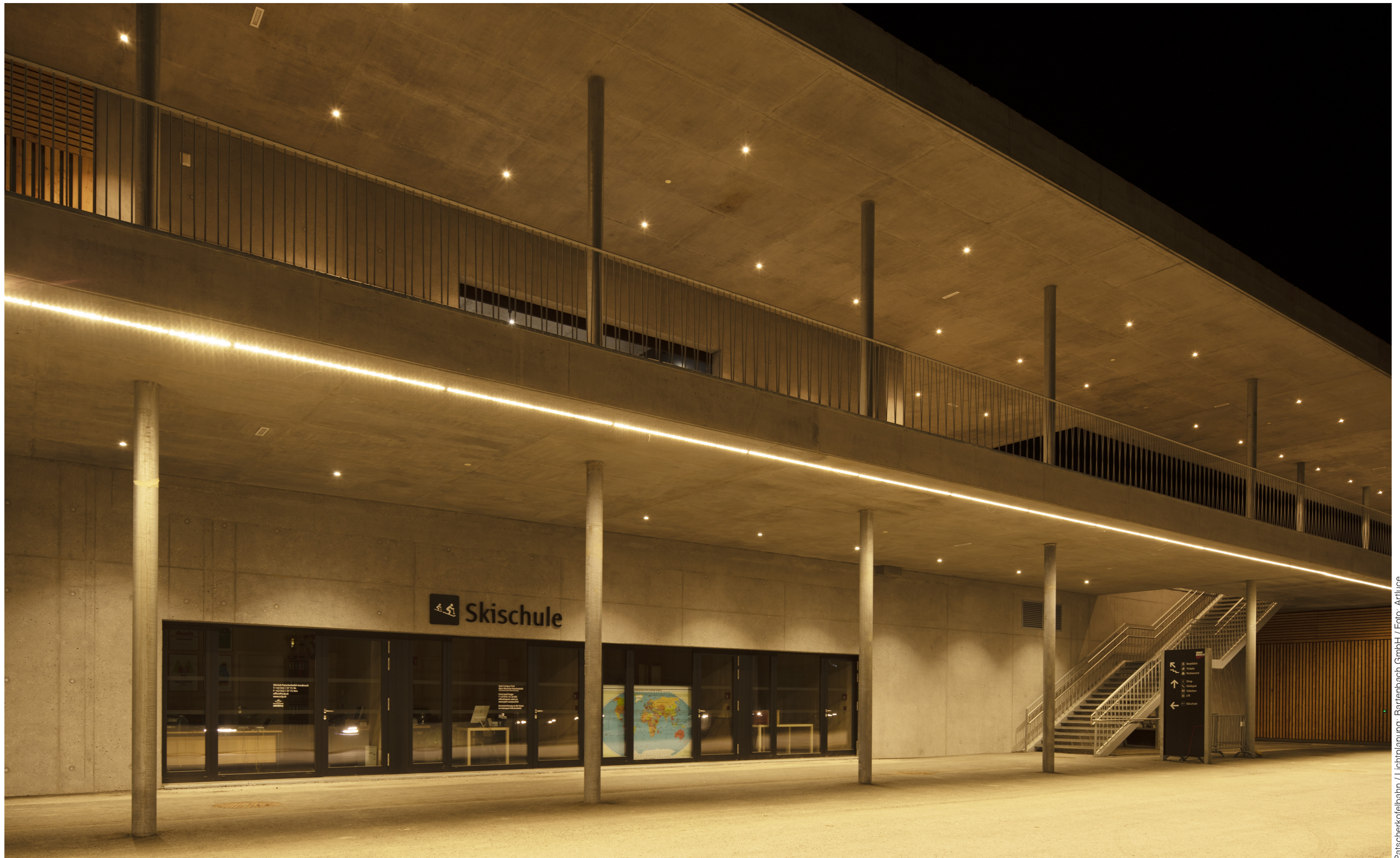
Patscherkofelbahn / Lichtplanung: Bartenbach GmbH / Foto: ArtLuce
